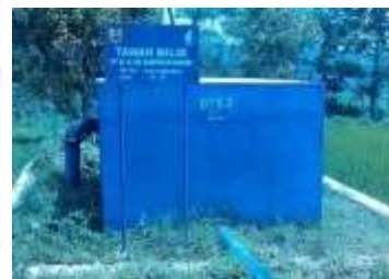
Gambar 3.14 Bak Pelepas Tekan (BPT)
